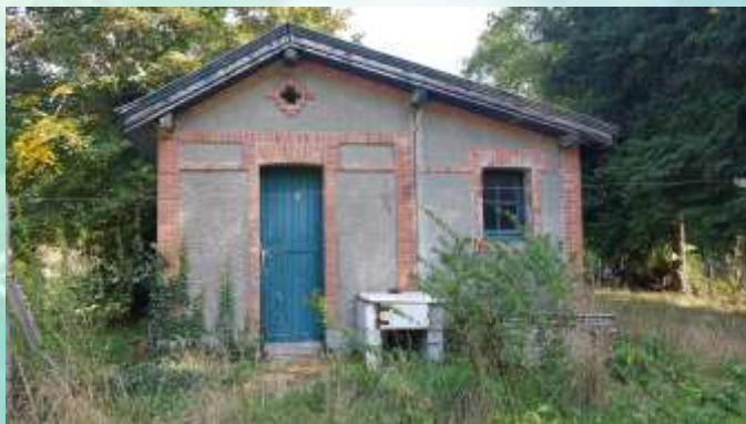
L'ancien abri des voyageurs à la gare
